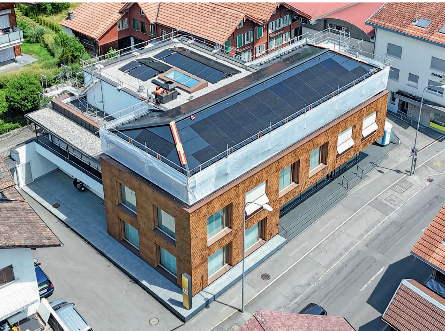
Installation der grossflächigen Photovoltaikanlage auf dem Dach des BBO-Bankgebäudes in Brienz.
